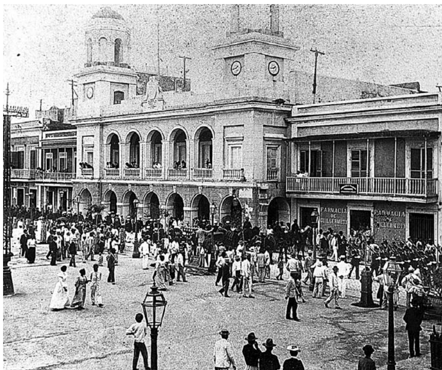
Ayuntamiento de San Juan, en cuyos bajos se instaló la sede de la Caja de Ahorros. Colección Puertorriqueña.
